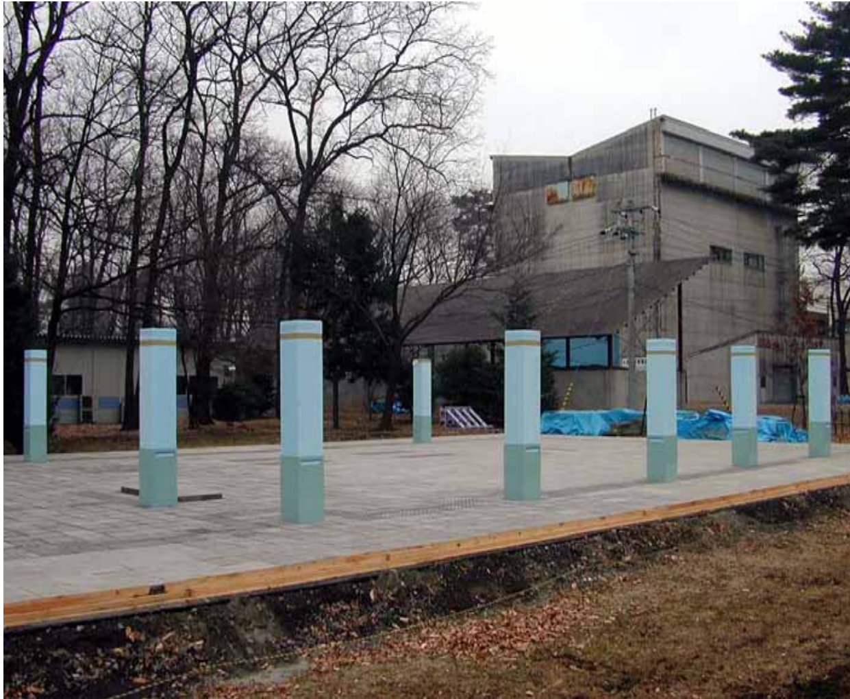
柱を立てた状態の実験場
