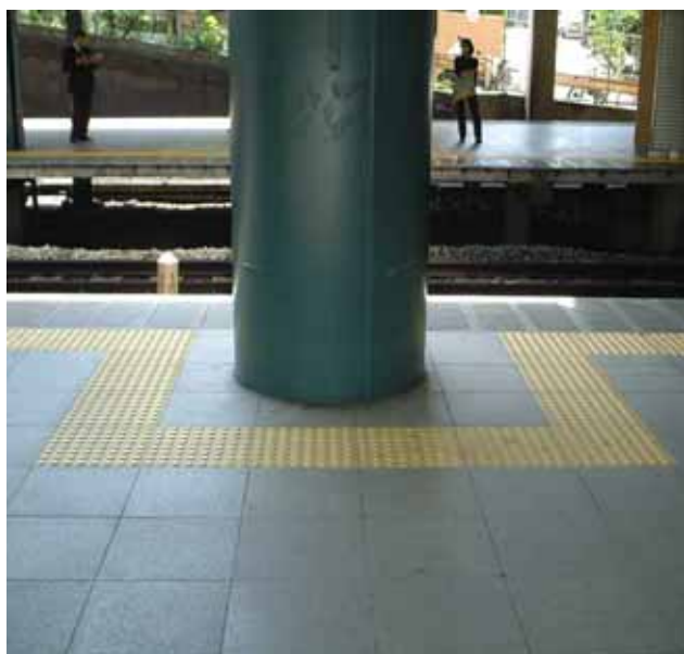
コの字迂回敷設
